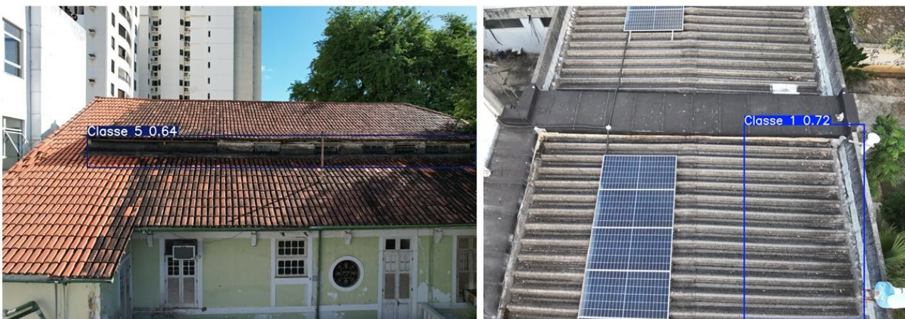
Figura 10: Exemplos de predições do modelo YOLOv11m. Nota: A classe 5 corresponde a presença de biofilme, e a classe 1 presença de sujeira na cobertura.
