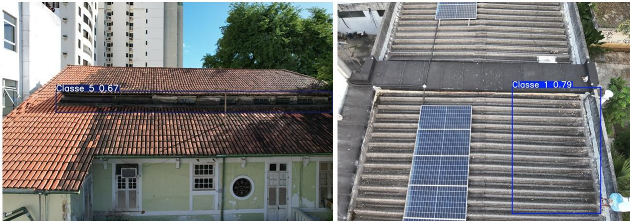
Figura 11: Exemplos de predições do modelo Yolov11l. Nota: A classe 5 corresponde a presença de biofilme, e a classe 1 presença de sujeira na cobertura.
