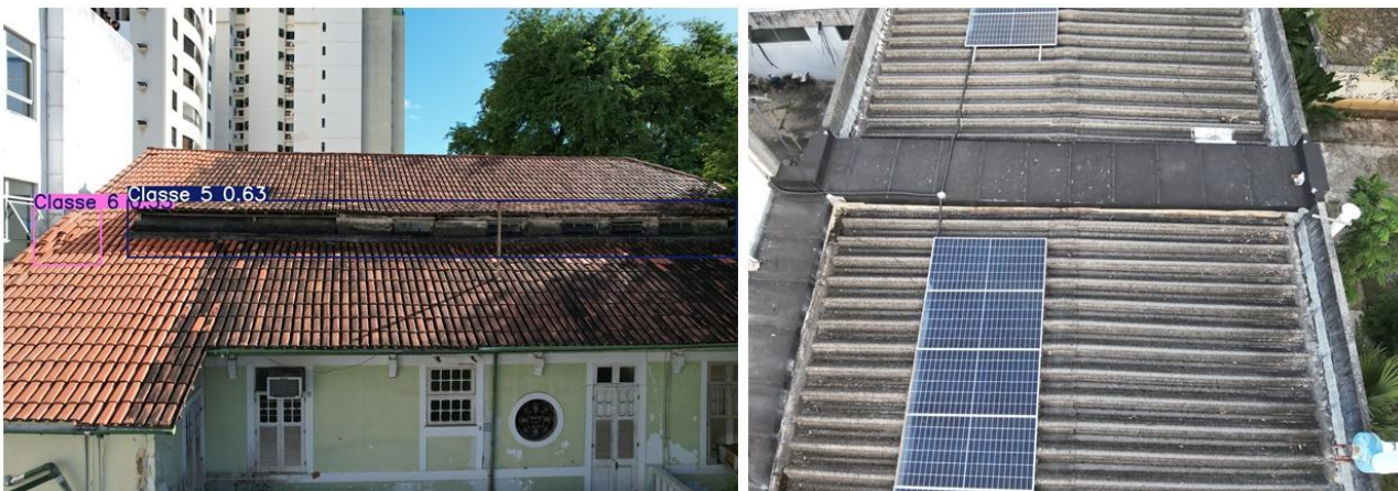
Figura 12: Exemplos de predições do modelo Yolov11x. Nota: A classe 5 corresponde a presença de biofilme, e a classe 1 presença de sujeira na cobertura.
