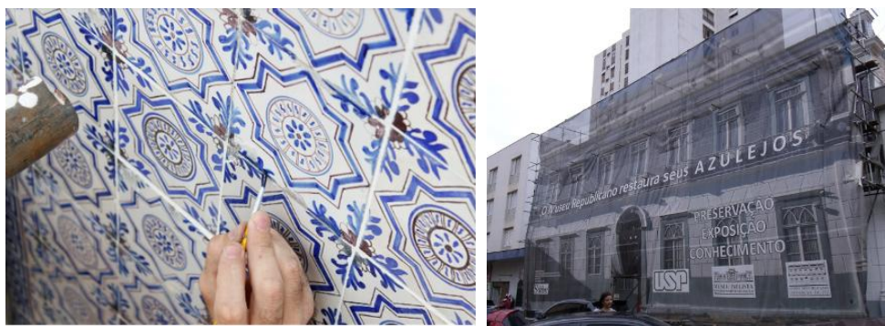
Figura 2: Fotografias da fachada durante o restauro de seus azulejos (à direita) e foto de detalhe dos azulejos sendo restaurados (à esquerda).
