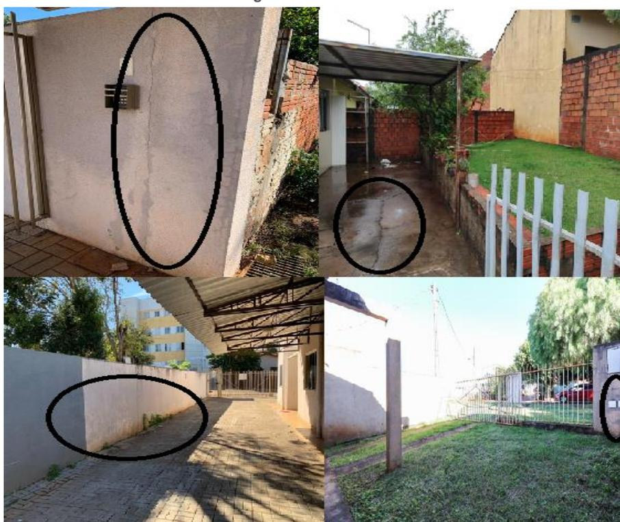
Problemas de rachaduras e fissuras foram mascaradas com pinturas ou camadas argamassadas. Em pisos externos, foram observadas irregularidades em terreno, acúmulo de água e pedaços soltos de revestimento.
