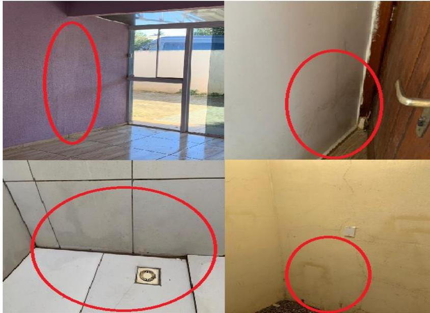
Outro fator constatado foi infiltração nas emendas, devido as ampliações feitas nas edificações. Na Figura 4 podem ser observadas infiltrações nas residências 4, 7, 8, 9 e 10.
