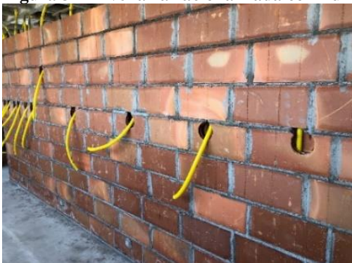
Figura 3 – Alvenaria racionalizada com furos verticais para a passagem de instalações
