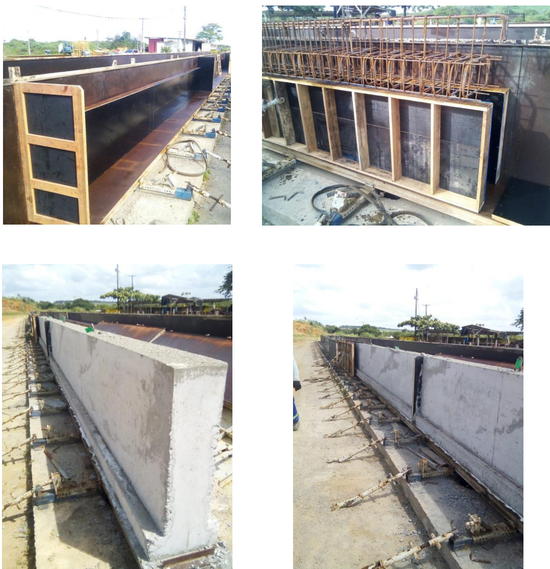
Figura 3: Limpeza e organização das fôrmas metálicas após implantação do 5S
