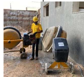
Figura 5 – Limpeza de maquinas
