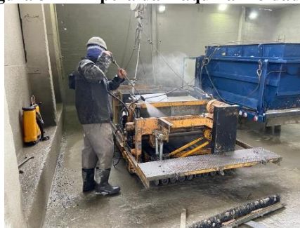
Figura 3 – Limpeza da máquina moldadora.
