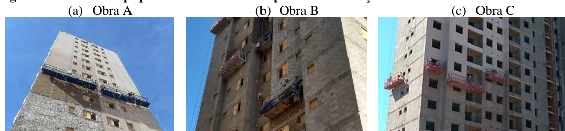
Figura 1 - Vista dos equipamentos balancins suspensos na execução do revestimento das fachadas
