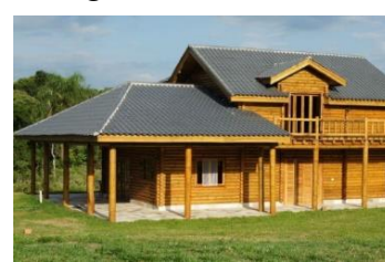
Figura 3 – Casa de campo em log home
