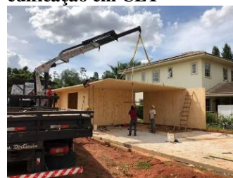
Figura 6 – Montagem de edificação em CLT
