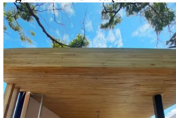
Figura 10 – Edificação em NLT
