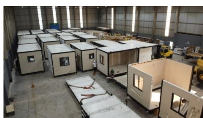
Figura 2 – Montagem em galpão de edificações em wood frame
