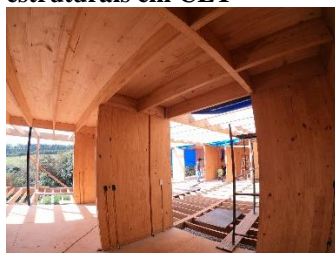
Figura 5 – Elementos estruturais em CLT
