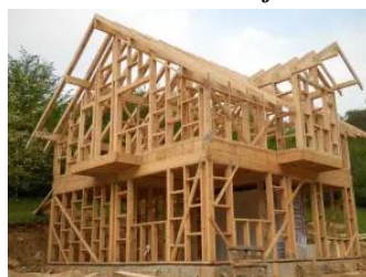
Figura 1 – Estrutura residencial em wood frame
