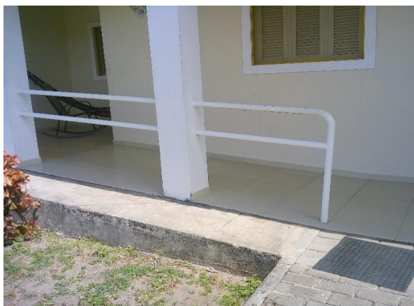
Figura 7: Vista lateral da rampa de entrada
