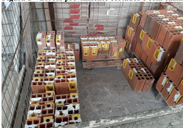
Figura 1 – Blocos previamente cortados e com caixas elétricas chumbadas na central de trinchos
