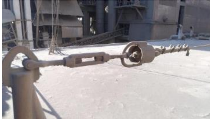
Figura 7: Linha de vida 16 – Detalhe Painel Central.
