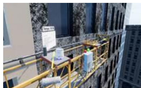
(b) Plataforma a 30 metros de altura.
