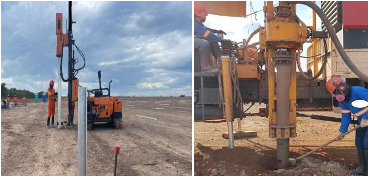
Figura 1: Cravação direta de estacas (à esquerda) e pre-drilling (à direita)
