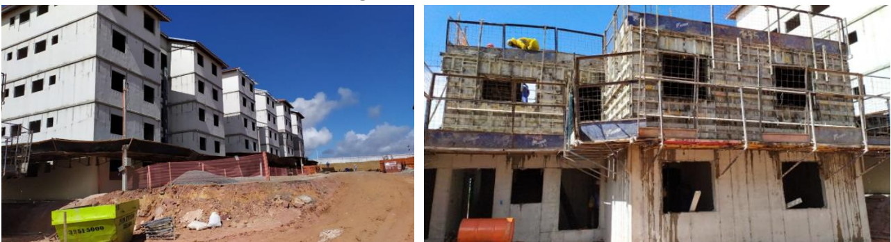
Figura 3: Canteiro de Obras.
