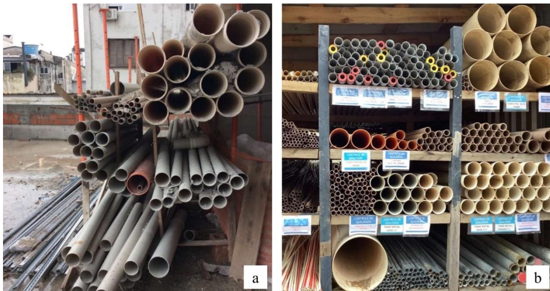
Figura 1: (a) evidência de falha no estoque das tubulações hidráulicas e (b) armazenamento correto do material hidráulico.
