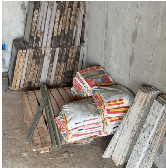
Figura 9: Armazenamento do material diretamente no apartamento
