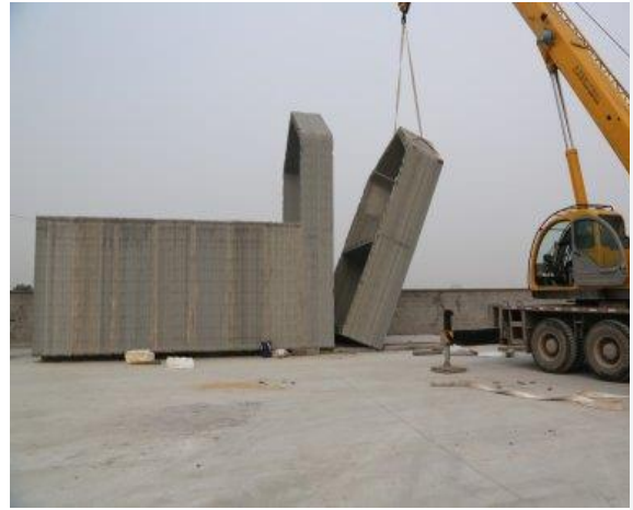
Figura 5: Montagem da casa impressa pela Winsun
