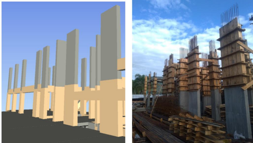
Figura 4: Concretagem dos pilares do pavimento garagem 1.
