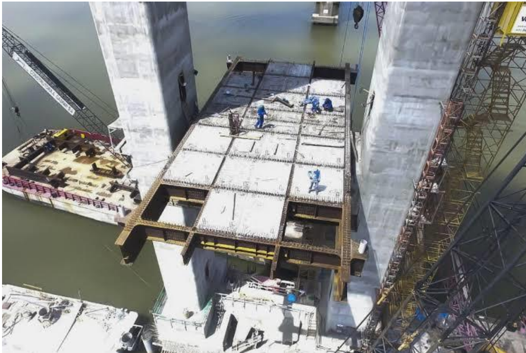
Figura 1- Fotografia retirada por drone na construção da ponte União em Moju (PA)
