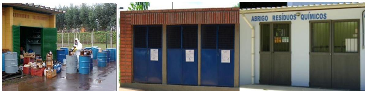
Figura 1 – Exemplos de abrigos temporários de resíduos na UFSCar, USP de Ribeirão Preto e UERJ
