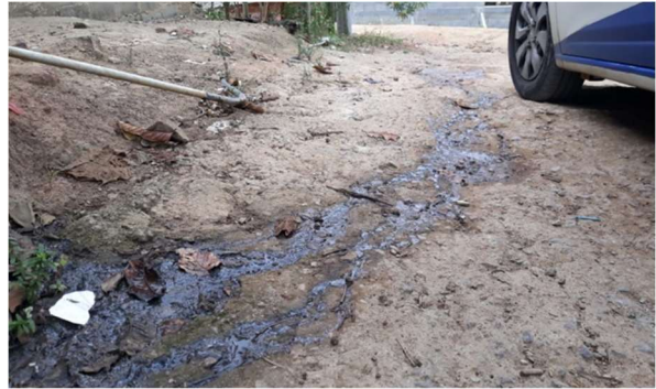
Figura 7 - Esgoto a céu aberto
