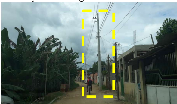
Figura 9 - Instalação de postes para rede de distribuição de energia elétrica
