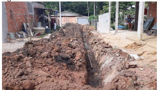
Figura 10 - Instalação de rede distribuição de água
