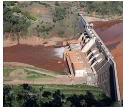
Figura 2 - Usina Risoleta Neves inoperante devido ao acúmulo de rejeitos próximo à crista da barragem.
