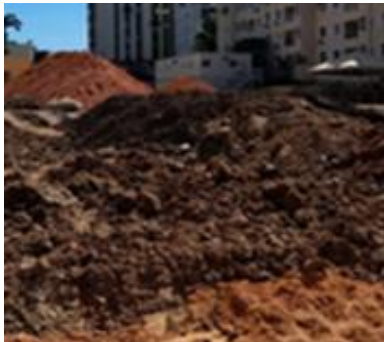
Figura 1 – Obra em que foi coletado o solo utilizado na pesquisa - Praça Seca, Rio de Janeiro.
