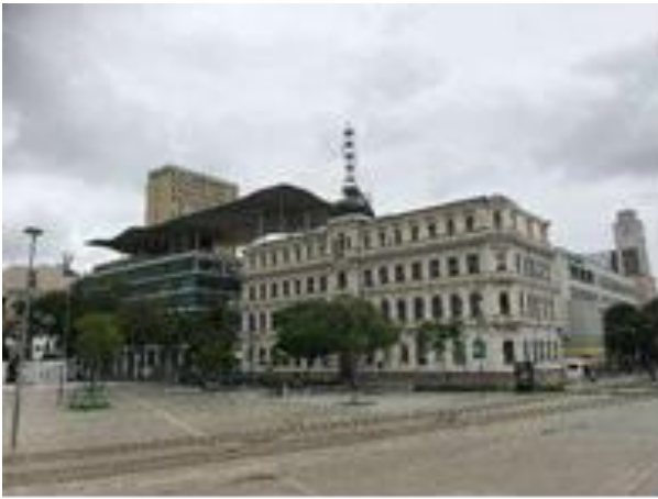
Figura 2 – Praça Mauá, Museu de Arte do Rio ( MAR), observa-se que a integração dos dois prédios, um de estilo eclético e outro modernista, através de uma grande laje ondulada como as ondas do mar..
