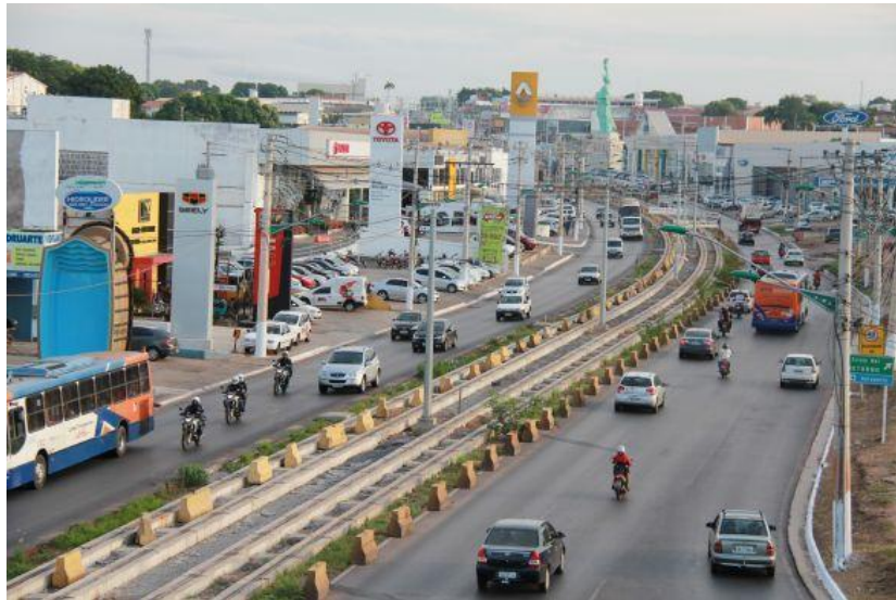
Figura 3 – Implantação do VLT na Avenida da FEB em Várzea Grande.
