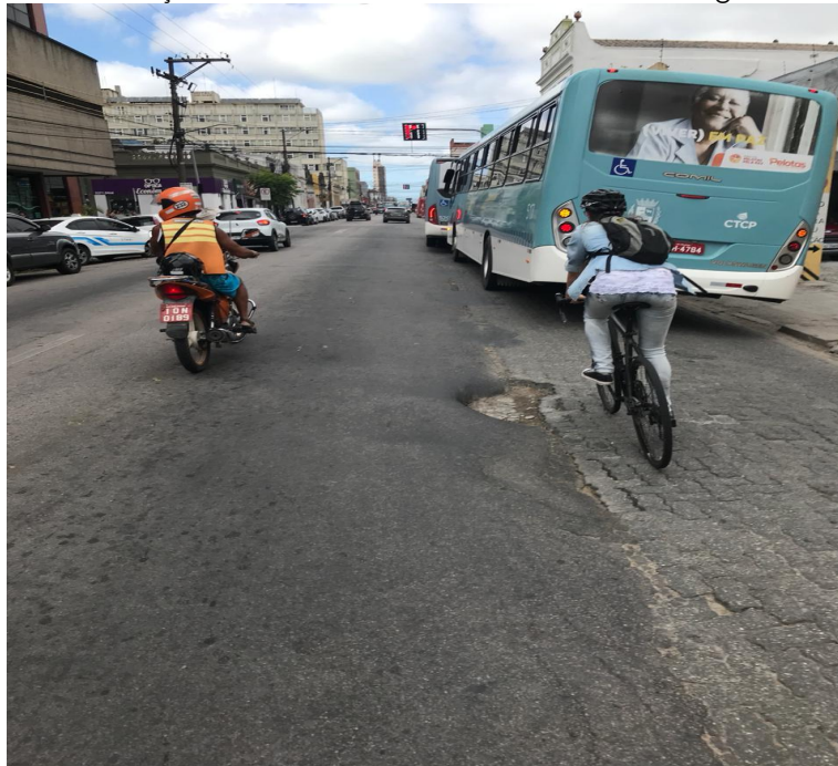
Figura 3 – Presença de buracos na via onde o ciclista é obrigado a desviar
