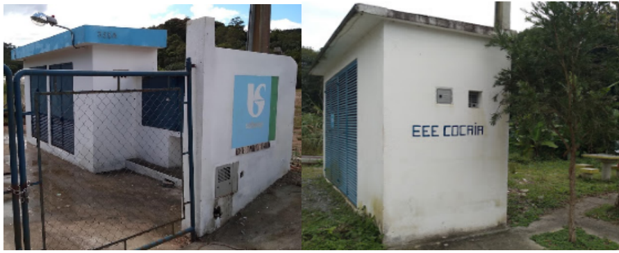
Figura 5 – Estações Elevatórias de Esgoto dos assentamentos
