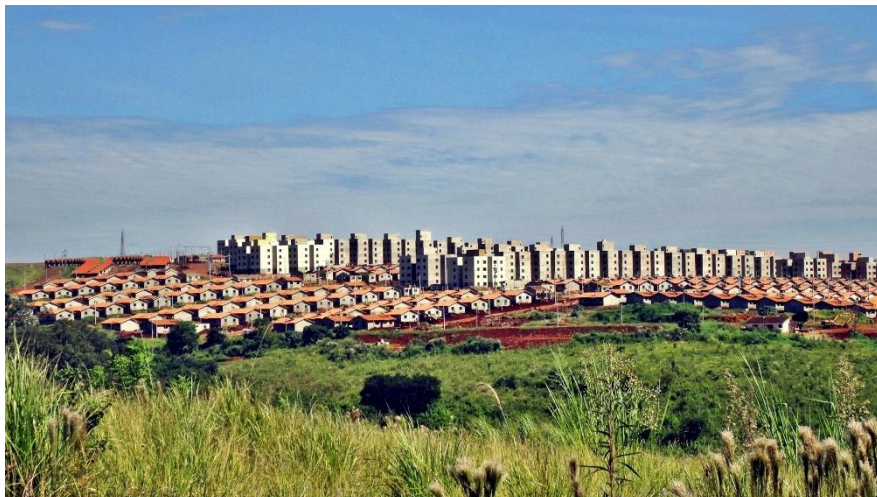
Figura 3 - Vista do Residencial Vista Bela.
