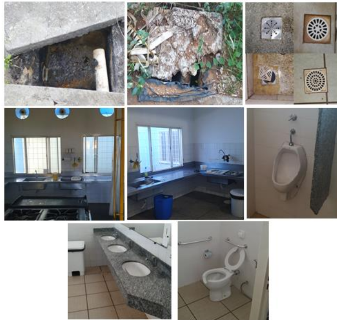
Figura 6- Aparelhos contribuintes para o esgoto - RU
