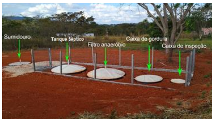
Figura 9 - Novo Sistema de tratamento de esgoto.
