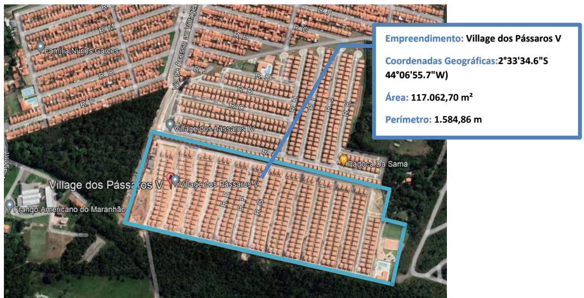
Figura 1 – Local do empreendimento - Condomínio Village dos Pássaros V.
