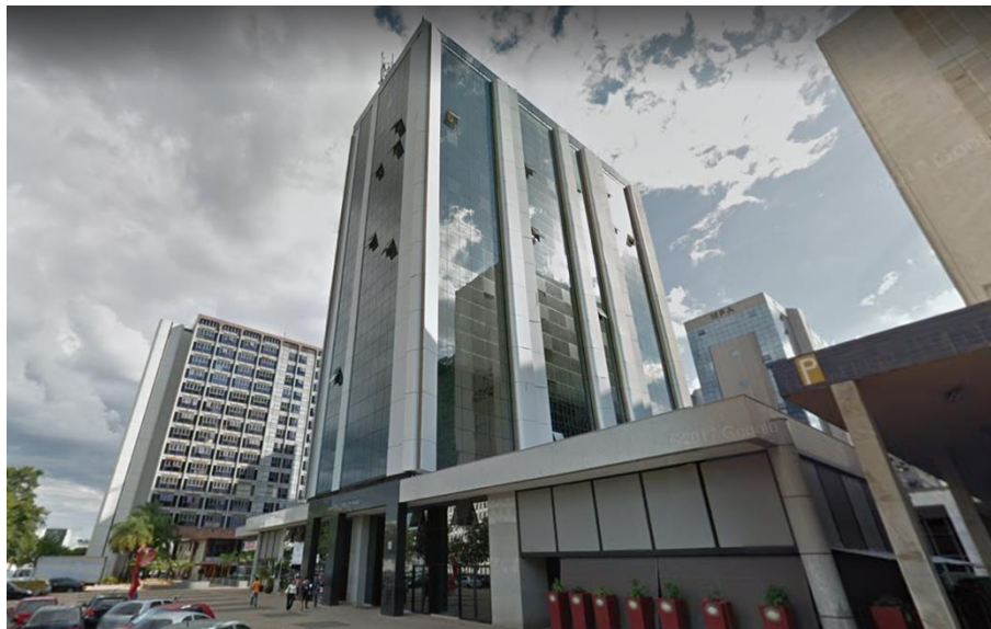
Figura 2 – Edificação de escritórios selecionado para o levantamento qualitativo.
