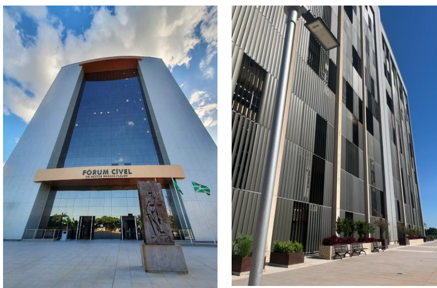
Figura 1 - Fachadas frontal e lateral da edificação.
