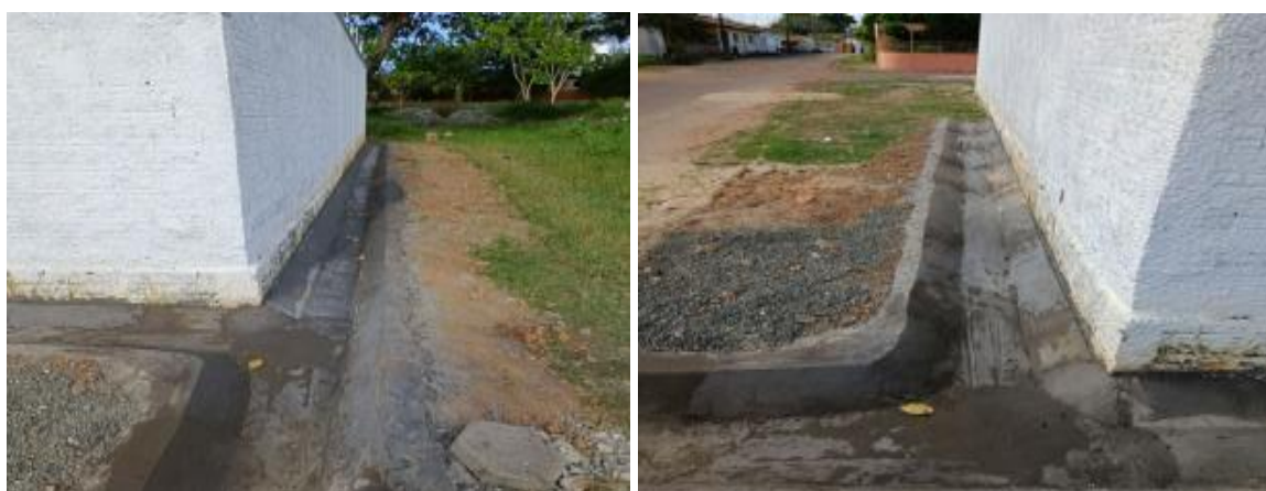
(a) Execução de canaletas em núcleo modular
