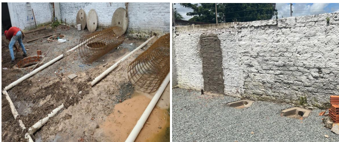
(b) Execução de drenagem pluvial em núcleo de alvenaria
