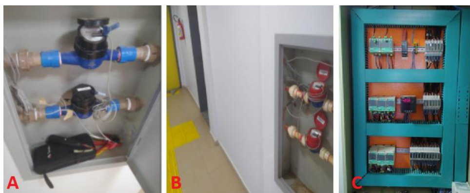
Figura 1 – Alguns hidrômetros de água fria (A) e quente (B), e painel do sistema (C)
