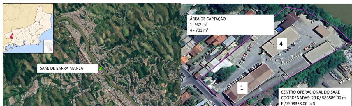
Figura 1 – Centro Operacional do SAAE de Barra Mansa-RJ
