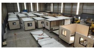
Figura 2 – Montagem em galpão de edificações em wood frame
