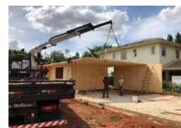
Figura 6 – Montagem de edificação em CLT
