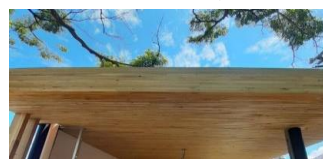
Figura 10 – Edificação em NLT
