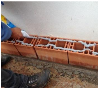
Figura 1 - Assentamento de alvenaria de junta fina de argamassa polimérica
