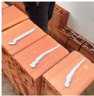
Figura 1 - Assentamento de alvenaria de junta fina de argamassa polimérica
