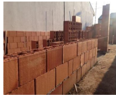
Figura 1 - Assentamento de alvenaria de junta fina de argamassa polimérica
