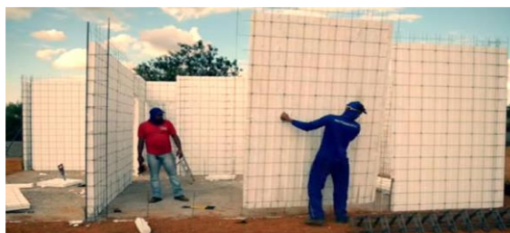
Figura 2 – Fixação dos painéis de EPS
