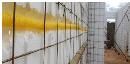
Figura 4 – Instalações inseridas embaixo das malhas de aço
