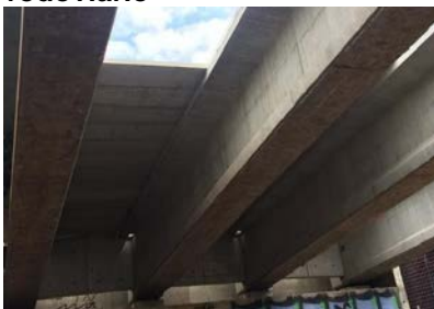
Figura 1 – Vista das longarinas do viaduto rodoviário
