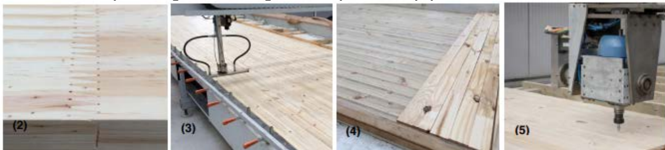
Figura 2 – Emenda finger joint. Figura 3 – Aplicação do adesivo estrutural. Figura 4 – Montagem do painel. Figura 5 – Usinagem de um painel no equipamento com CNC.
