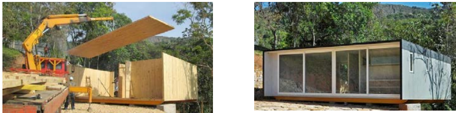
Figura 8 – Montagem da primeira residência em CLT no Brasil. Figura 9 – Residência finalizada.
