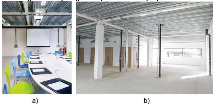
Figura 2 – Tipologias do piso misto de pequena altura.
