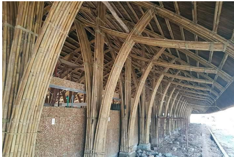
Figura 11 – Detalhe da tesoura sendo posicionada
