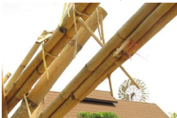
Figura 6 – Detalhe do feixe com bambu da espécie Dendrocalamus strictus
