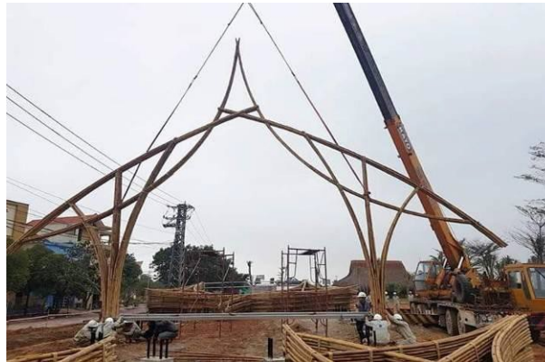
Figura 10 – Detalhe da tesoura sendo posicionada
