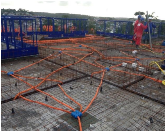
Figura 7 – Etapa 05: montagem de armaduras e instalações elétricas na laje
