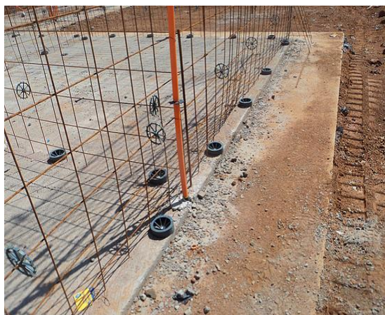
Figura 4 – Etapa 02: marcação das paredes
