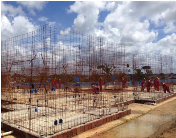
Figura 7 – Etapa 05: montagem de armaduras e instalações elétricas na laje
