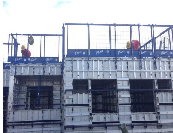
Figura 8 – Etapa 06: concretagem de paredes e lajes
