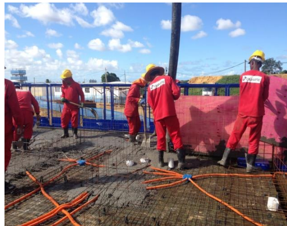
Figura 8 – Etapa 06: concretagem de paredes e lajes
