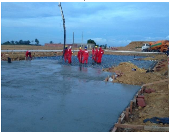
Figura 3 – Etapa 01: execução de fundação em radier protendido
