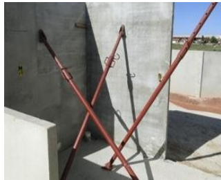
Fotografia 3 – Escoramento e travamento dos painéis (autores, 2015)
