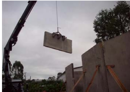
Fotografia 2 – Montagem dos painéis por meio de caminhão munck (autores, 2015)
