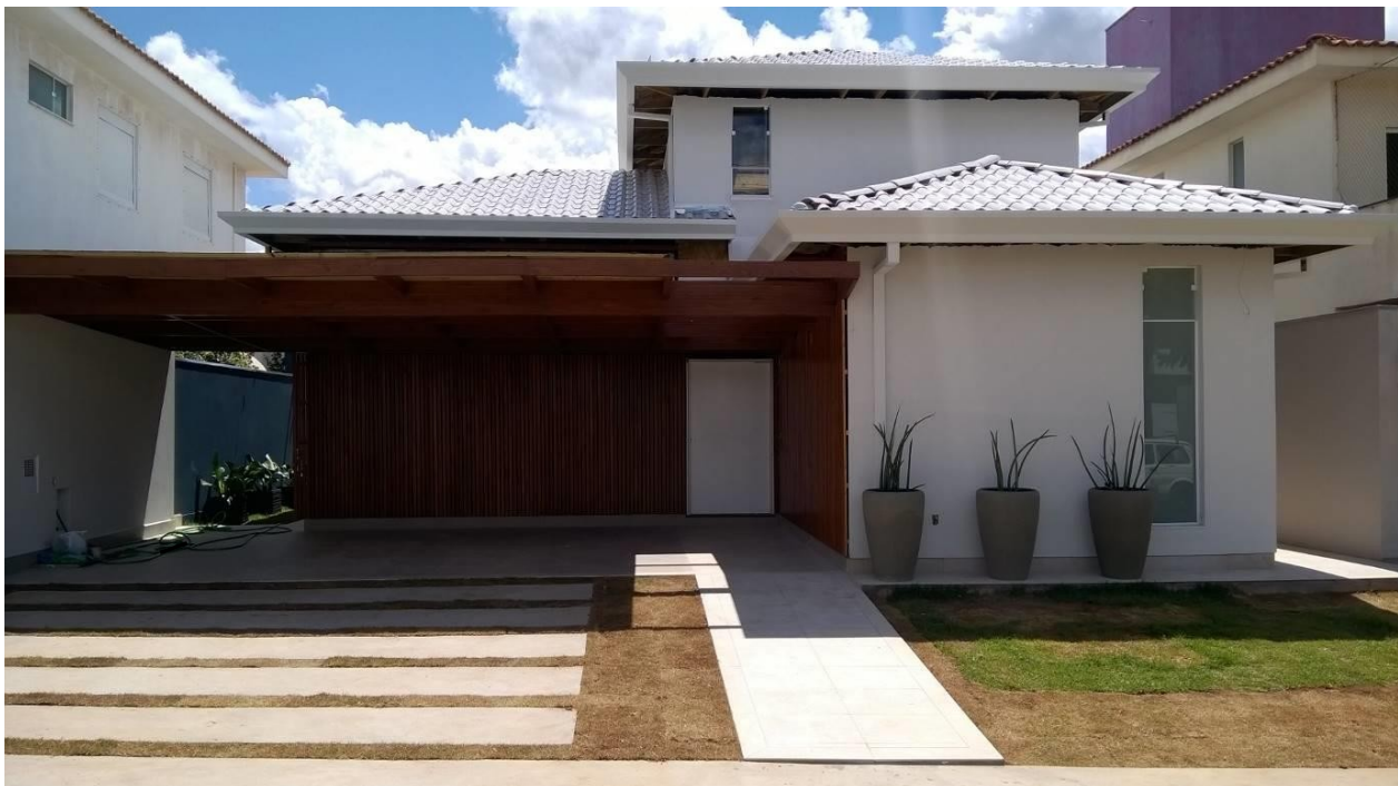
Figura 1 – Habitação em wood frame avaliada, localizada na cidade São Carlos-SP.
