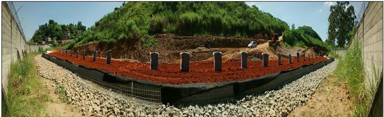
A compactação de cada camada é extremamente importante uma vez que é fato crucial para o bom desempenho da obra. Na Figura 7 observam-se as diferentes compactações a próxima a face com uso do “sapo-mecânico” e a da camada feita com uso de rolo compressor do tipo pé-de-carneiro.
