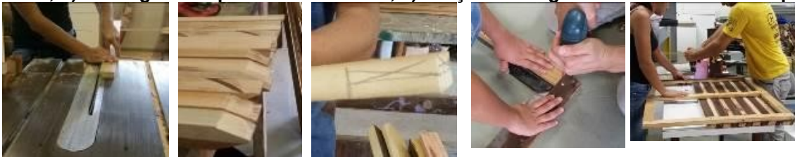
Figura 3 - a) regularização das peças; b) réguas com ângulos; c) marcação para corte de meia madeira; d) montagem do quadro estruturante; e) fixação das réguas de revestimento no quadro.
