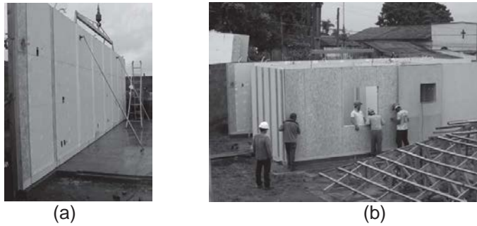
Figura 3 – Painéis em wood frame alocados em fundação tipo Radier
