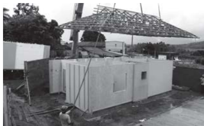
Figura 4 – Estrutura de telhado sendo alocada em edificação em wood frame
