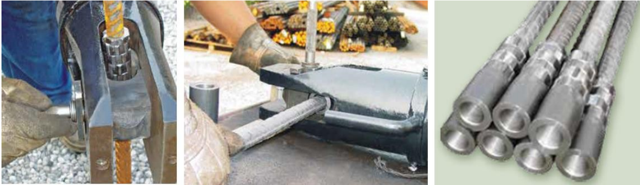
Figura 10 - Uso de prensa hidráulica para confecção de luvas prensadas
