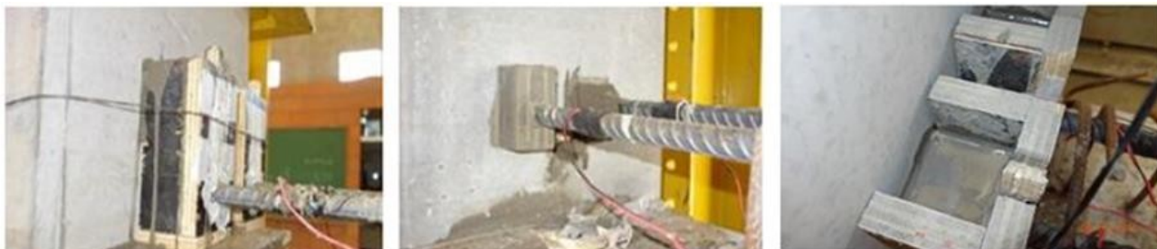
Figura 6 - Preenchimento das bainhas com graute por meio de vasos comunicantes
