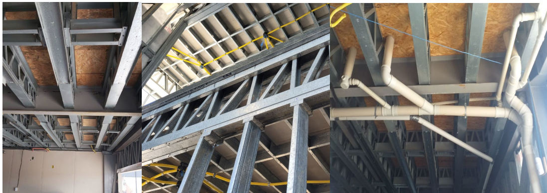
Figura 1: Laje seca e instalações elétricas e hidrossanitárias.
