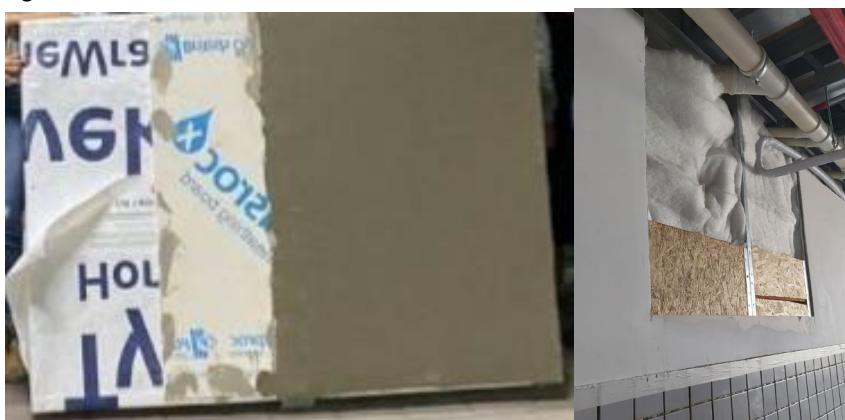
Figura 2: Revestimento externo e isolamento térmico e acústico no revestimento interno.
