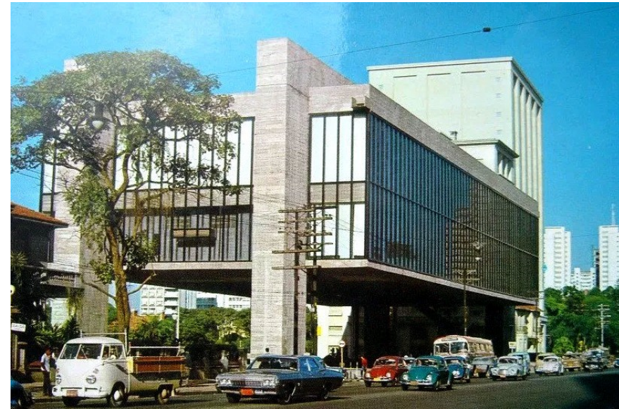
MASP (07/11/1968) - vão livre = 74m, vigas protendidas com 2,50m de altura
