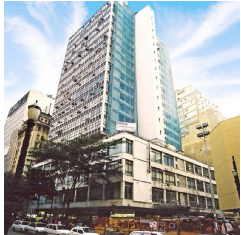
Palácio do Comércio – início da década de 2000 Reforma geral e escada de segurança
