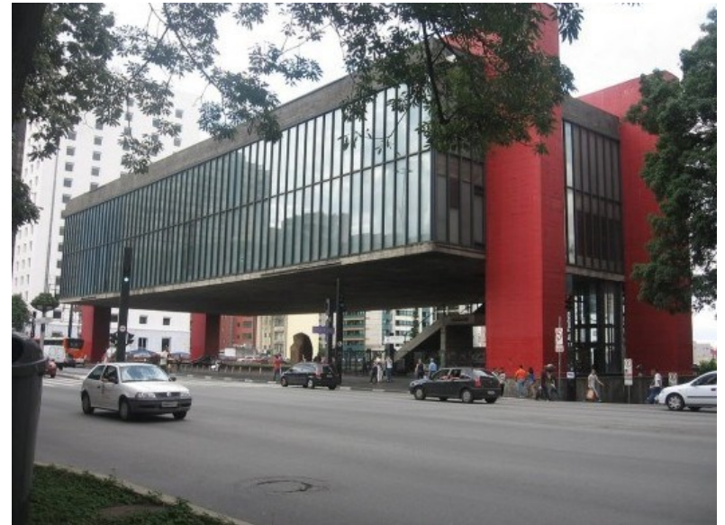
MASP (07/11/1968) - vão livre = 74m, vigas protendidas com 2,50m de altura
