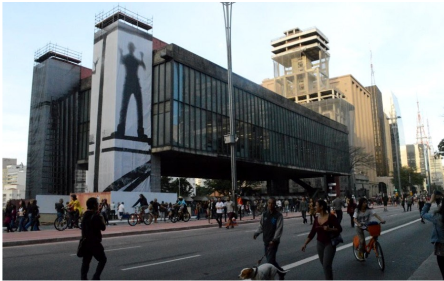
MASP (07/11/1968) - vão livre = 74m, vigas protendidas com 2,50m de altura
