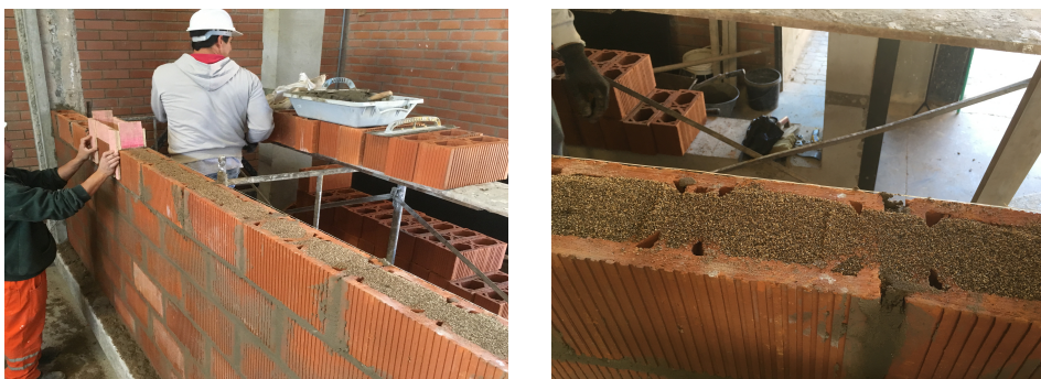
Figura 1 – Construção da amostra em sistema de pórtico
